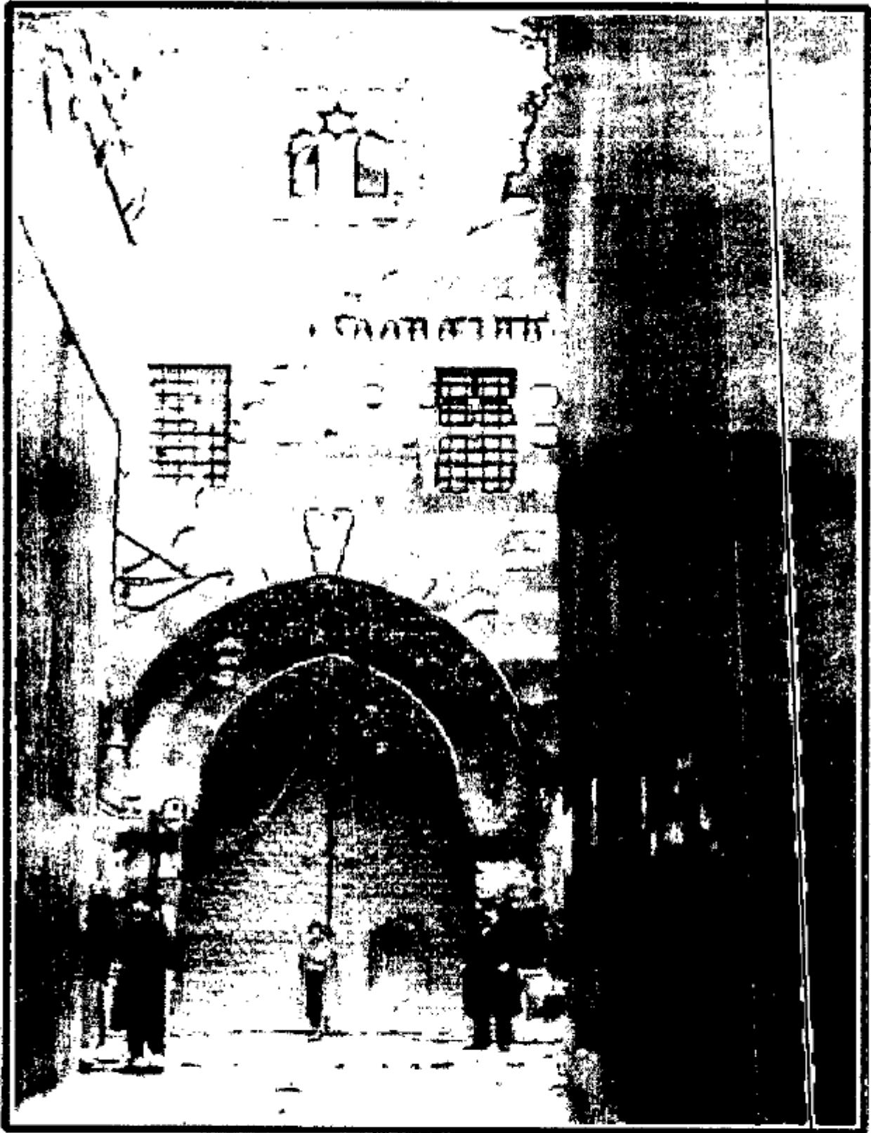
خان الوزير. (الواجهة الخارجية) (façade extérieure) Khan al-Wazir.
