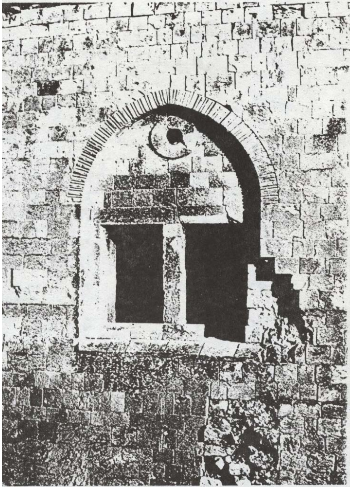
الواجهة الشمالية من علالى تبه ، وهي بيت الشيخ يوسف الشريدة الذي اقامه كرمز للزعامة والحكم اخلي في قضاء عجلون .
