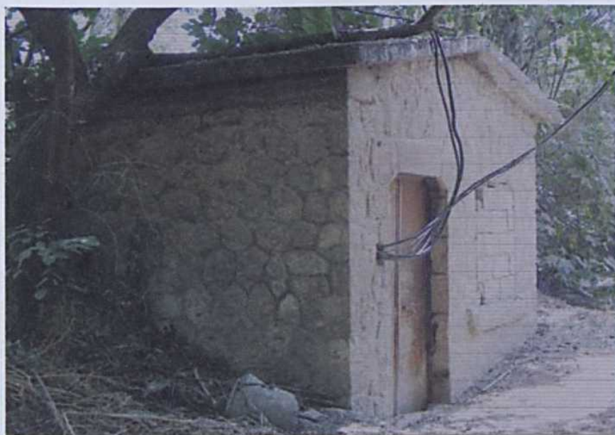
(صورة ١٩) مشروع الري من عين الميدان - غرفة المضخة
