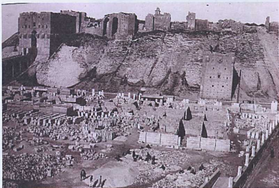
(صورة ٢٦) أساسات مبنى السراي الجديدة أمام القلعة عام ١٩١٦.
