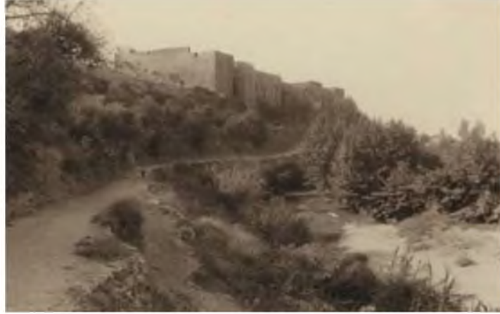
(الصورة ١٨) طرابلس القلعة - الصورة مطلع القرن ٢٠م
