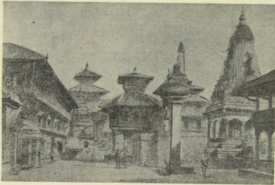
الصورة الثالثة - مزيج من فن البناء يدل على تأثير العمود الأجنبية ، ميدان بهات غاؤون ، التقط المؤلف صورته في أثناء زيارته نيبال، تدل هذه المباني على المؤثرات الصينية أول وهلة .
