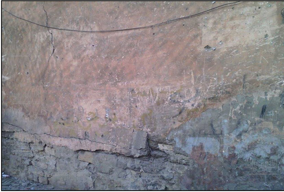
صورة (8): توضح تآكل المداميك السفلى بأحد جدران المسجد ووجود شروخ بالغة وفقد في طبقة الملاط ، أيضا التعديات البشرية المتمثلة في الكتابة على جدران المسجد.
