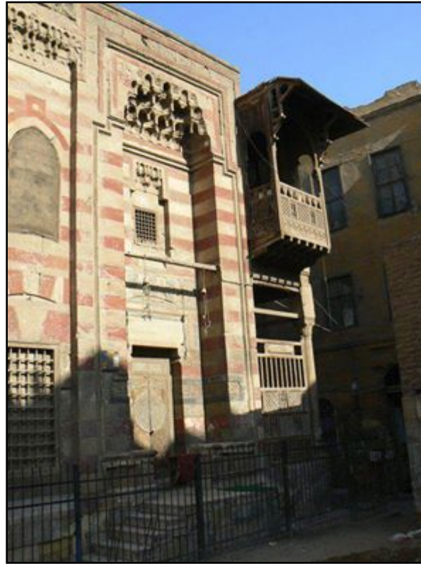
صورة (2): يوضح المدخل الرئيسي للمدرسة ويتضح وجود الكتاب والسبيل.
