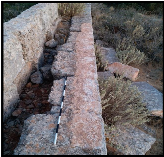
صورة (19) هدم متعمد لكنتل البناء بالجدار الغربي
