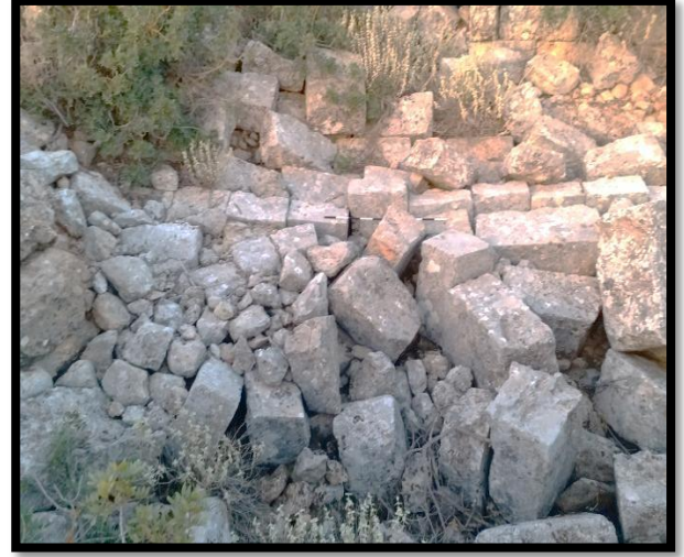
صورة(10،11) انهيار الجدار الغربي بفعل الزلازل
