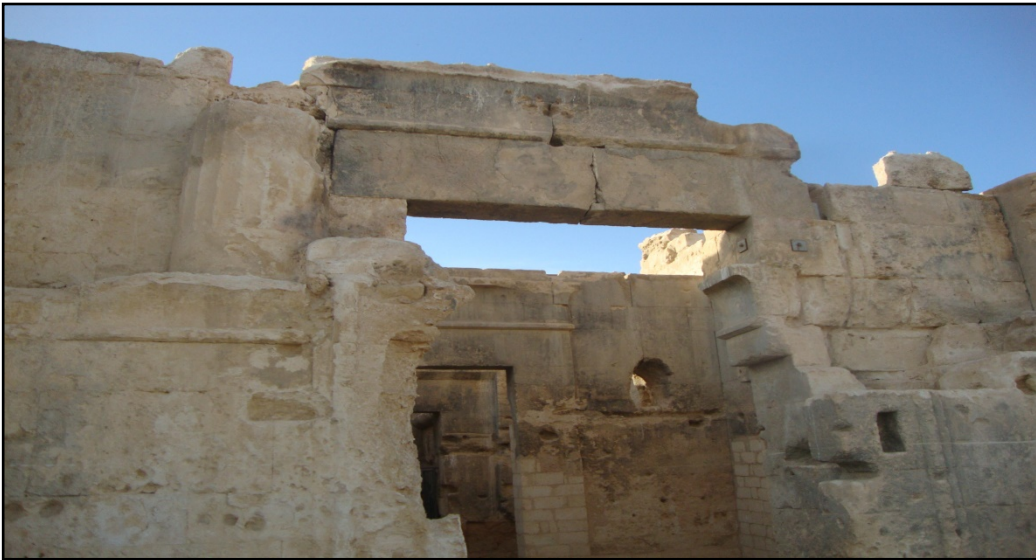
صورة (5): توضح مدخل معبد الوحي بسيوة ، ويتضح مدى ضعف الحجر الجيري الملحي وتآكله مما يهدد
