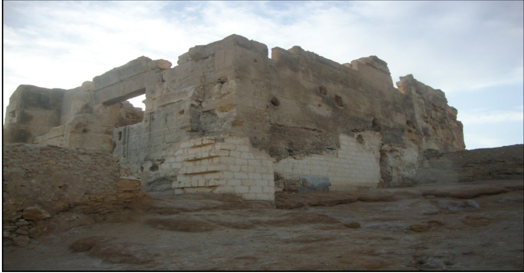
صورة (3): توضح بناء منازل الأهالي بالكرشيف في واحة سيوة (تصوير الباحث)
